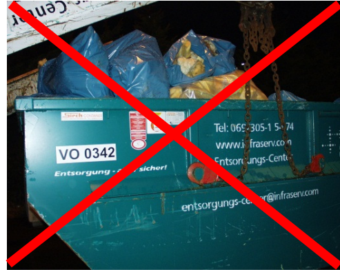
Fehlanlieferung: unverpackte, defekte Säcke mit Mineralfasern
