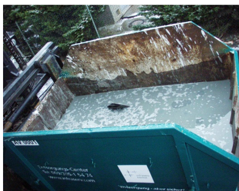
Folgen einer nicht abgeplanten Mulde
